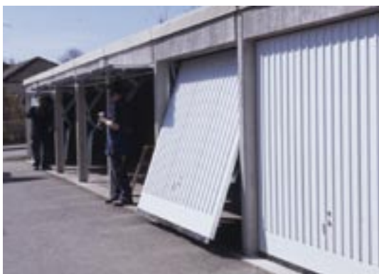
Porten är färdigjusterad på fabrik och kan tas i bruk direkt efter monteringen.
