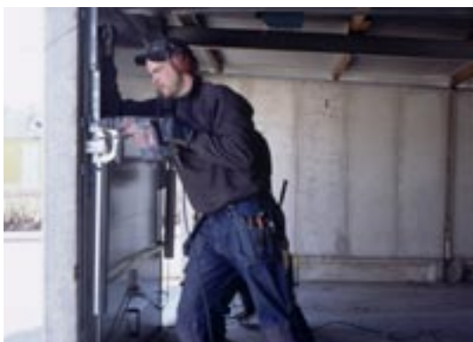
Två man ställer porten i sitt läge och skruvar fast karmen, utan skrymmande skenor i taket.
