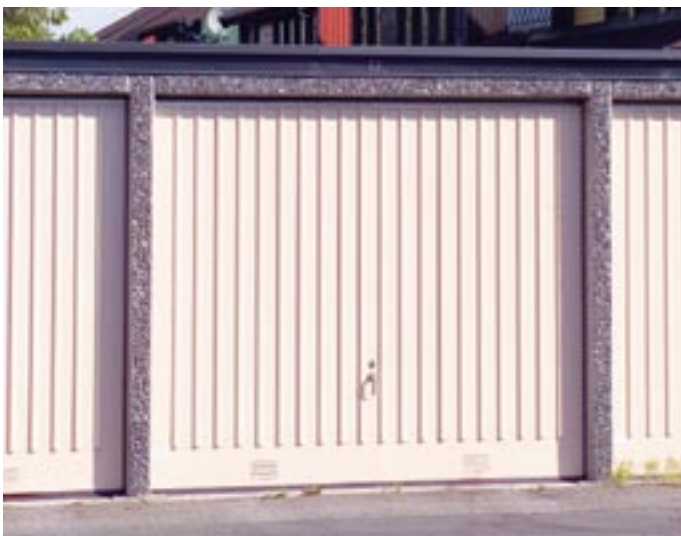
Dieden Favorit är som gjord för S:t Eriks betonggarage genom sin konstruktion med infästning av karmen.
