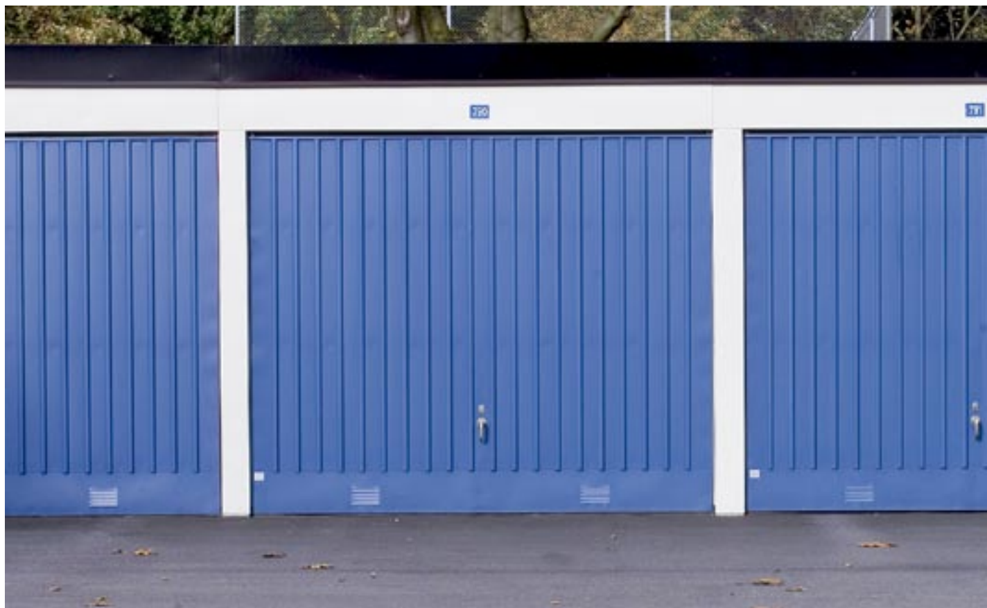
Portar i signalblå kulör, och försedda med ventiler i sparkplåten.
